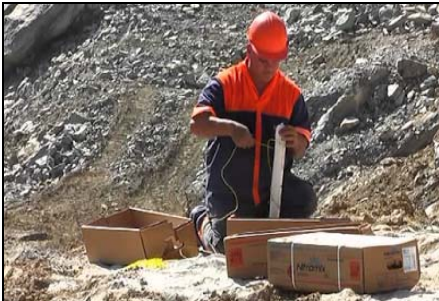
Figura 5 - Carregamento dos furos com explosivos - fonte internet acessado em 05/12/2016.
